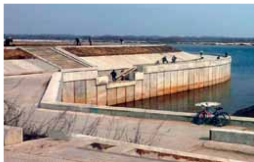
Бетонная набережная в Балахне на месте нахождения соляных колодцев
